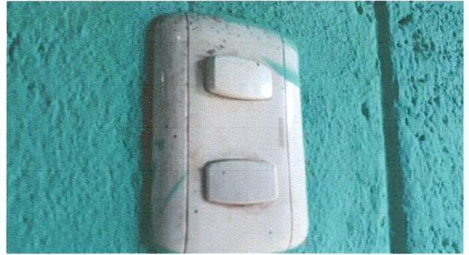
Foto 2: Reparación de Sistema Eléctrico 2 aulas 1 bodega y Dirección.
