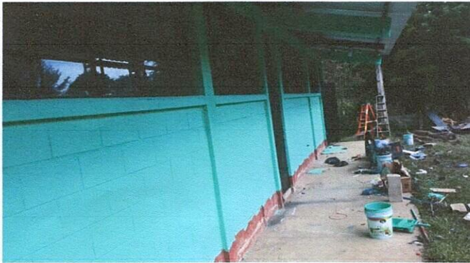
Foto 3: Pintura general de dos Aulas y dos Puertas
